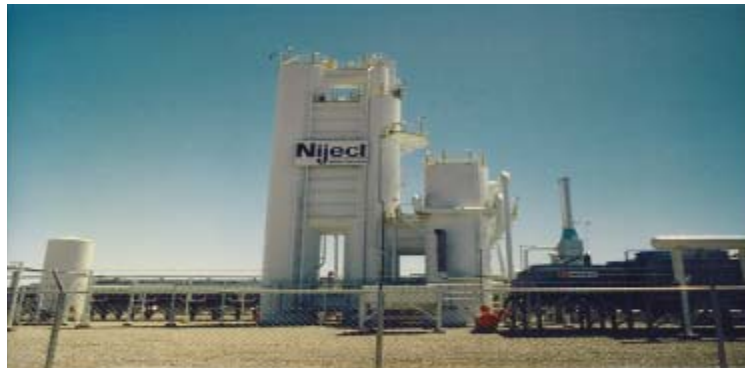
Anschutz 50 MMcfd / 6000 psig
